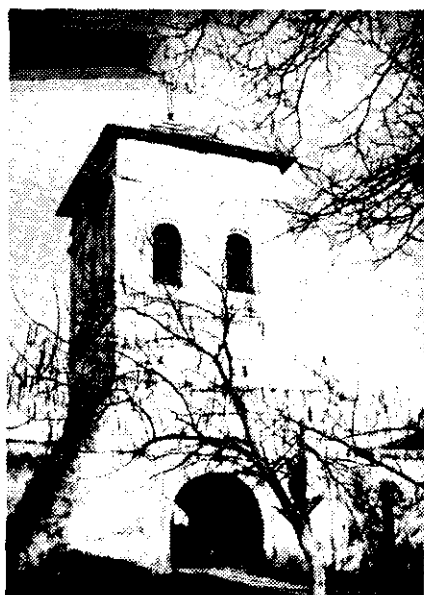
Fig.23. Turnul clopotniță - fațade de est după restaurare.
