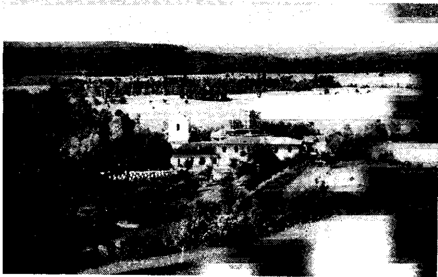
Fig.2. Vedere generală a mănăstirii în cursul lucrărilor de restaurare.
