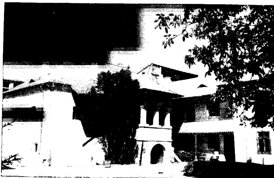
17. Casa parohială. Foișorul după restaurare. 17. La maison paroissiale. Le balcon, après restauration.
