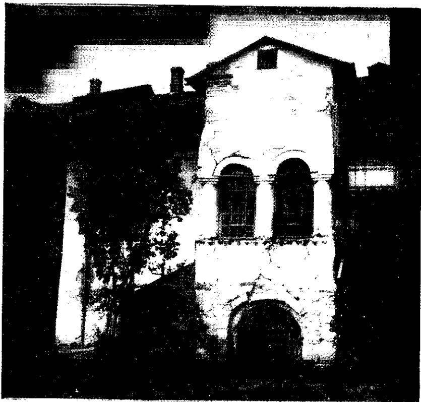
16. Casa parohială. Foișorul înainte de restaurare. 16. La maison paroissiale. Le balcon, avant restauration.
