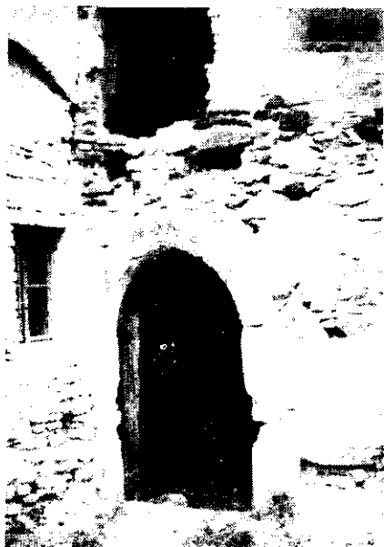
10. Portalul capelei. 10. Portail de la chapelle.
