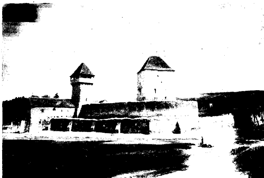
1. Vedere generală a cetății din Cîlnic.
