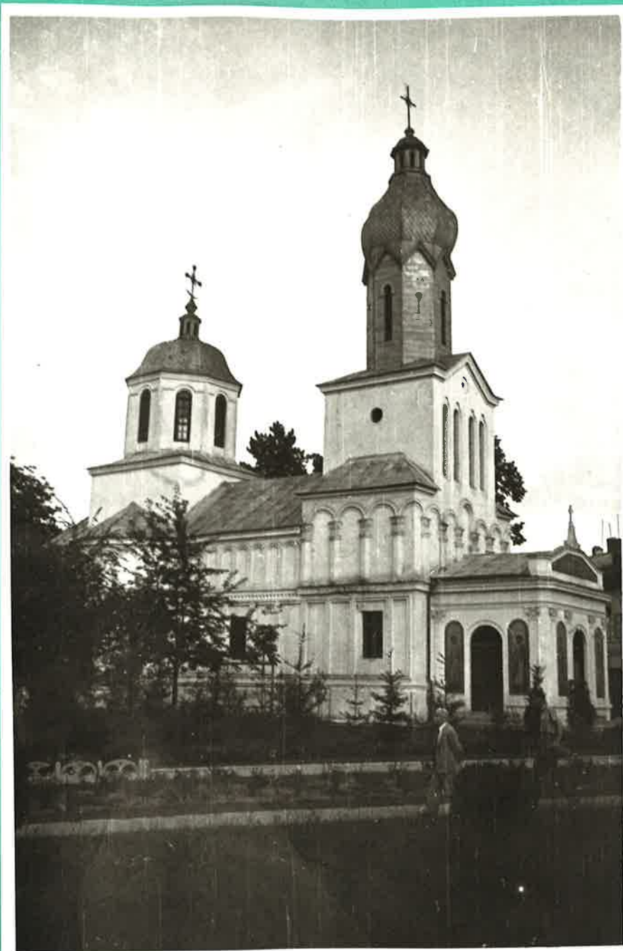
Biserica înainte de restaurare fațada de Nord-Vest
