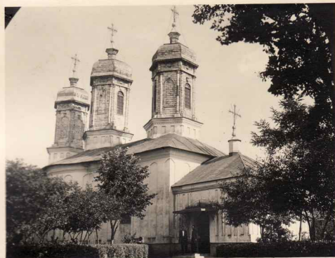
1. Vedere dinspre nord-vest
