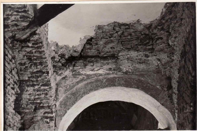
1. Pridvorul, bolta părții laterale nord alipită de peretele vechi al bisericii
