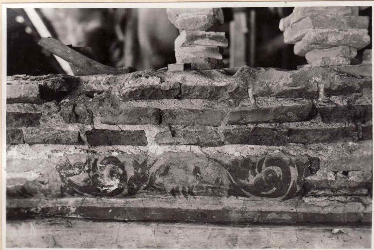
1. Urma din vechia cornișă, azi cuprinsă în pod, la pronaos perete nord
