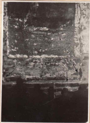
1. Fațada vest. Acoperiș înălțat, zidărie fronton, paiață
