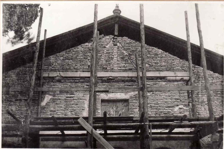
1. Fațada vest. Acoperiș înălțat, zidărie fronton, paiață
