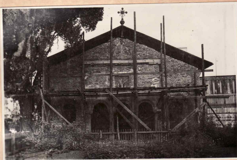
1. Fațada vest în timpul restaurării. Frontonul și zidăria la părțile laterale în partea superioară, sînt de palantă, acoperișul a fost înălțat cu renciuri
