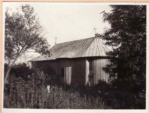
2. Învelitoare de tablă bătută peste cea veche de șită. Pereții căptușiți cu scinduri
