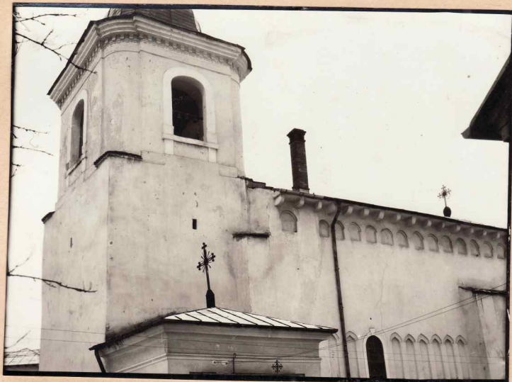
1. Vedere dinspre sud-vest
