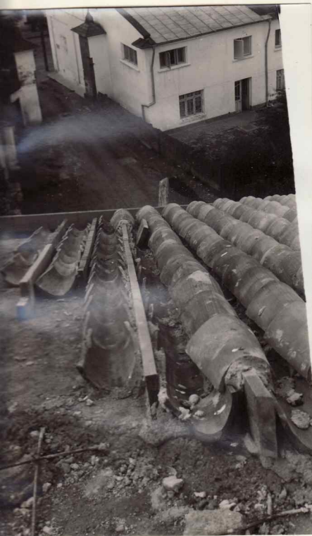
2. Coama învelitoarei noi de olane Se observă șipca între olane pentru înșurubarea stratului superior și betonul armat de 10 cm. grosime turnat peste stratul de moloz
