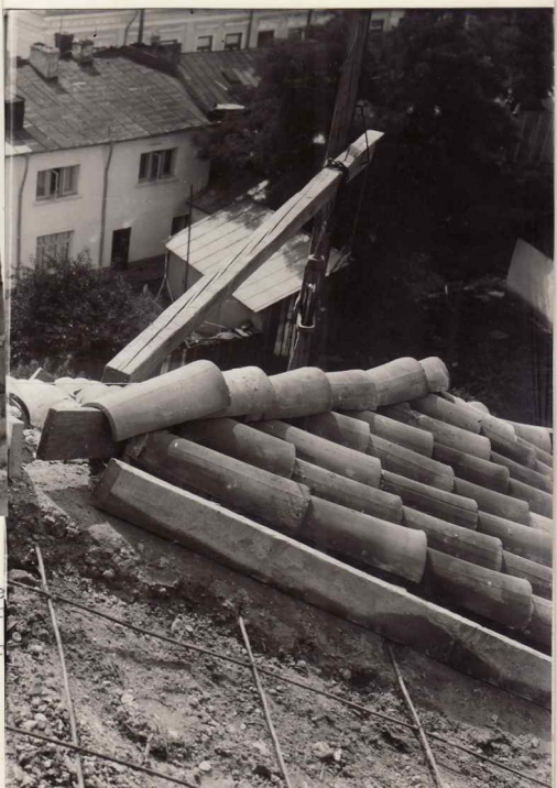
2. Coama învelitoarei noi de olane Se observă șipca între olane pentru înșurubarea stratului superior și betonul armat de 10 cm. grosime turnat peste stratul de moloz
