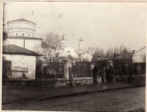
3! Grilaj la stradă C. Negri, după reface
