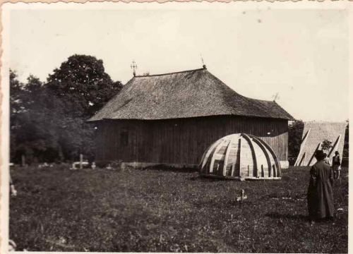
2. Vedere dinspre nord-vest
