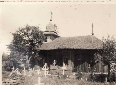
2. Vedere dinspre sud - E.
