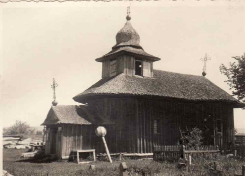
1. Vedere dinspre sud-vest
