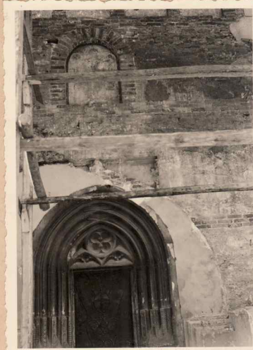
Latura Nord 2. Ușa după dărîmarea pridvorului înainte de curățirea părții superioare
