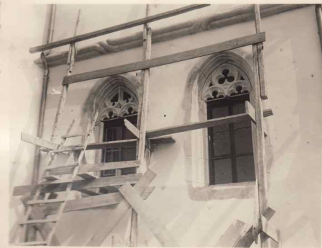
2. Fereastră fațada sud pronaos
