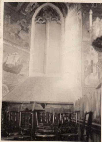
2. Fereastră pridvor spre nord zidită cu perete de 14 cm. dân cauza antepridvorului.
