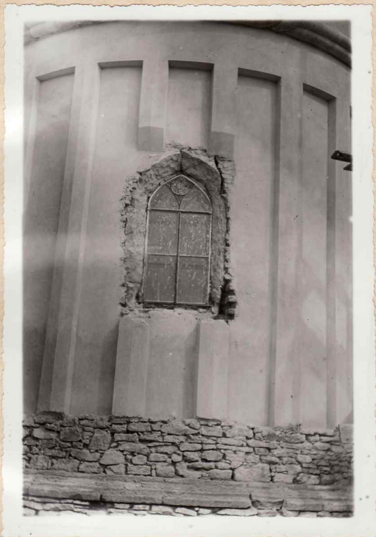
1. Peretele sud al absidei în timpul restaurării din 1937
