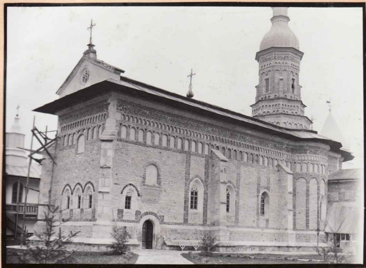
1. Vedere dinspre sud-vest
