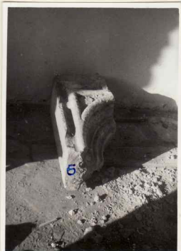
22. Fragmente de coronă- ment de fereastră colț stînga-găsit în urma dărămării stîlpilor ar- cului de sprijin al co- șului bucătăriei.
