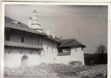
15. Detaliu fațadă sud exterior incintă
