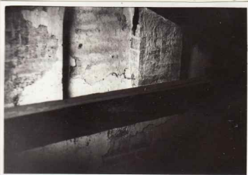
5. Urme de frescă în imitație de cărămida păstrate în podul vestmîn- tăriei.
