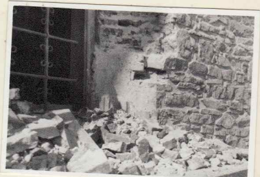
1. Biserica, Fereastră sud gropnița în cursul desfacerii încadrământului de ipsos
