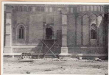
21. Biserica, fațada sud
