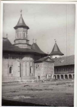
16. Fațadă Sud Mns. Moad.
