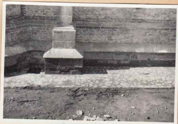
20. Biserica, fațada nord - detaliu
