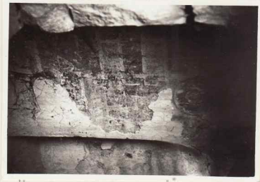
1. Urme de frescă în imitație de cărămidă în podul vestmântăriei
